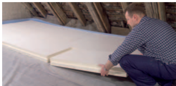
Ostatnia kondygnacja izolowana od strony strychu nieogrzewanego płytami LINITHERM PGV.
